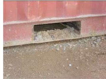
**Figure 6.3 - Boue dans un passage de fourches**
