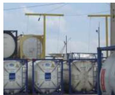
**Figure 8.12 - Chandeliers permettant d'arrêter les chutes**
